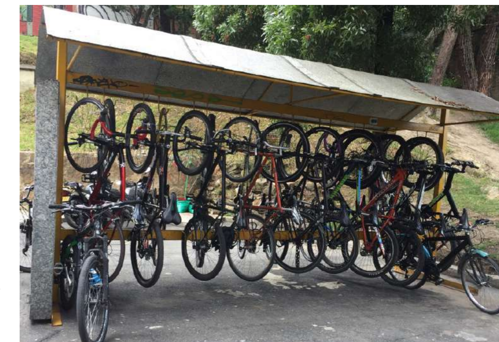
Bicicparqueadero sede Macarena A, su techo y panel para publicidad están elaborados en Tetra Pack
